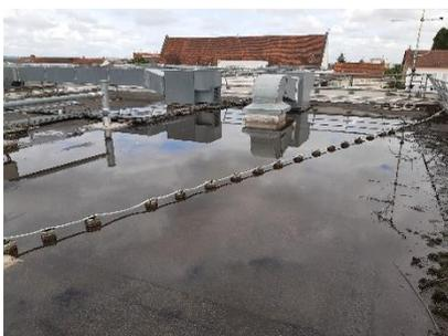
Photo 6 : Toiture en eau et sans bonde d'évacuation
