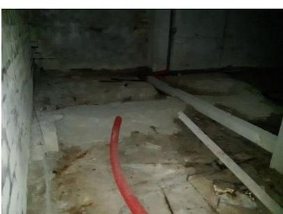
Photos 17 à 19 : Vides sanitaires sous les bâtiments PT1 et PT2 avec traces d'humidité et d'eau
