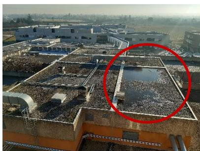
Photo 3 : Partie de la toiture en eau bâtiment A
