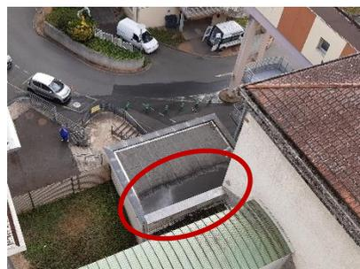
Photo 8 : Avancée de toit en eau côté sud
