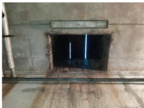
Photo 16 : Plaque métallique non hermétique au plafond et donnant sur l'extérieur
