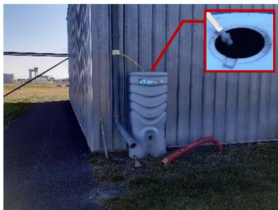
Photo 10 : Récupérateur d'eau pluviale rempli et non fermé
