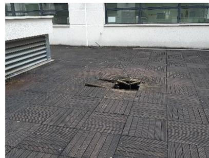
Photo 12 : Caillebotis abimés par l'eau et l'humidité
