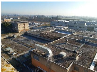
Photo 2 : Toitures terrasses du bâtiment A recouvertes de graviers
